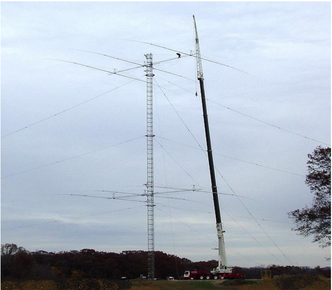
Bild 1: Amateur-Antennenanlage für 80 und 160 m mit OM in luftiger Höhe. Der gesamte Turm ist auf einer Bergkristallkugel isoliert gelagert und kann mit 20 0/s gedreht werden.
